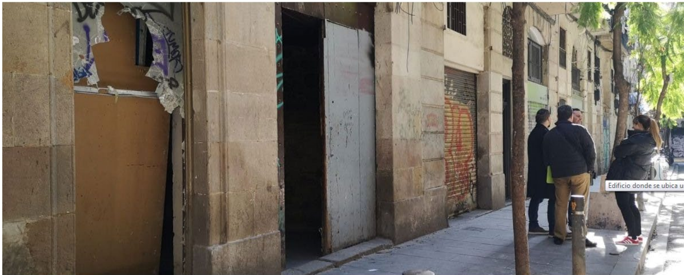
Edificio donde se ubica uno de los narcopisos del Raval, en la calle Príncipe de Viana / G.A
